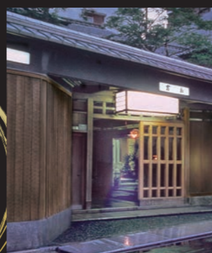
▲「料亭 老松」外観
